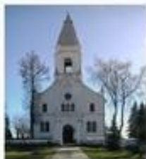
Bažnyčia iš vakarų pusės
