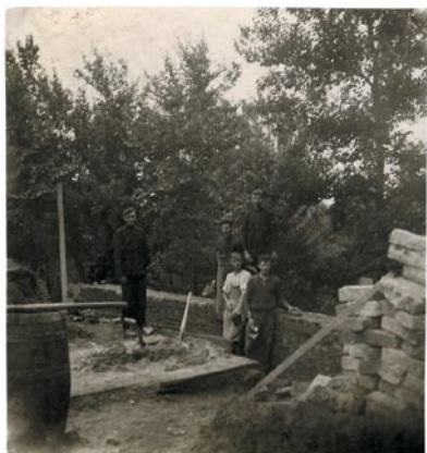
Šventoriaus sienelės statyba Smetonos laikais
