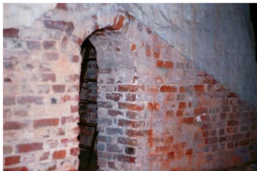
Bokšto detalė virš lubų. Netinkuota dalis, matyt, rodo buvusio stogo vietą prieš XIX a. pab. rekonstrukciją. R. Skrinško nuotrauka
