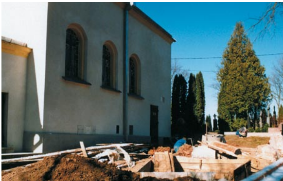
Grunto tvirtinimo darbai 1998 03 11. R. Skrinsko nuotrauka
